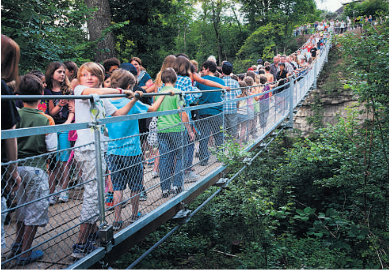
Die neue Hängebrücke in Obermeilen überwindet ein 25 Meter tiefes Tobel.
